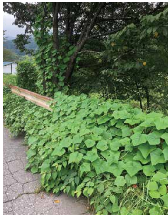
茂沢発電所のガードレールを覆うアレチウリ (撮影:須永久)
